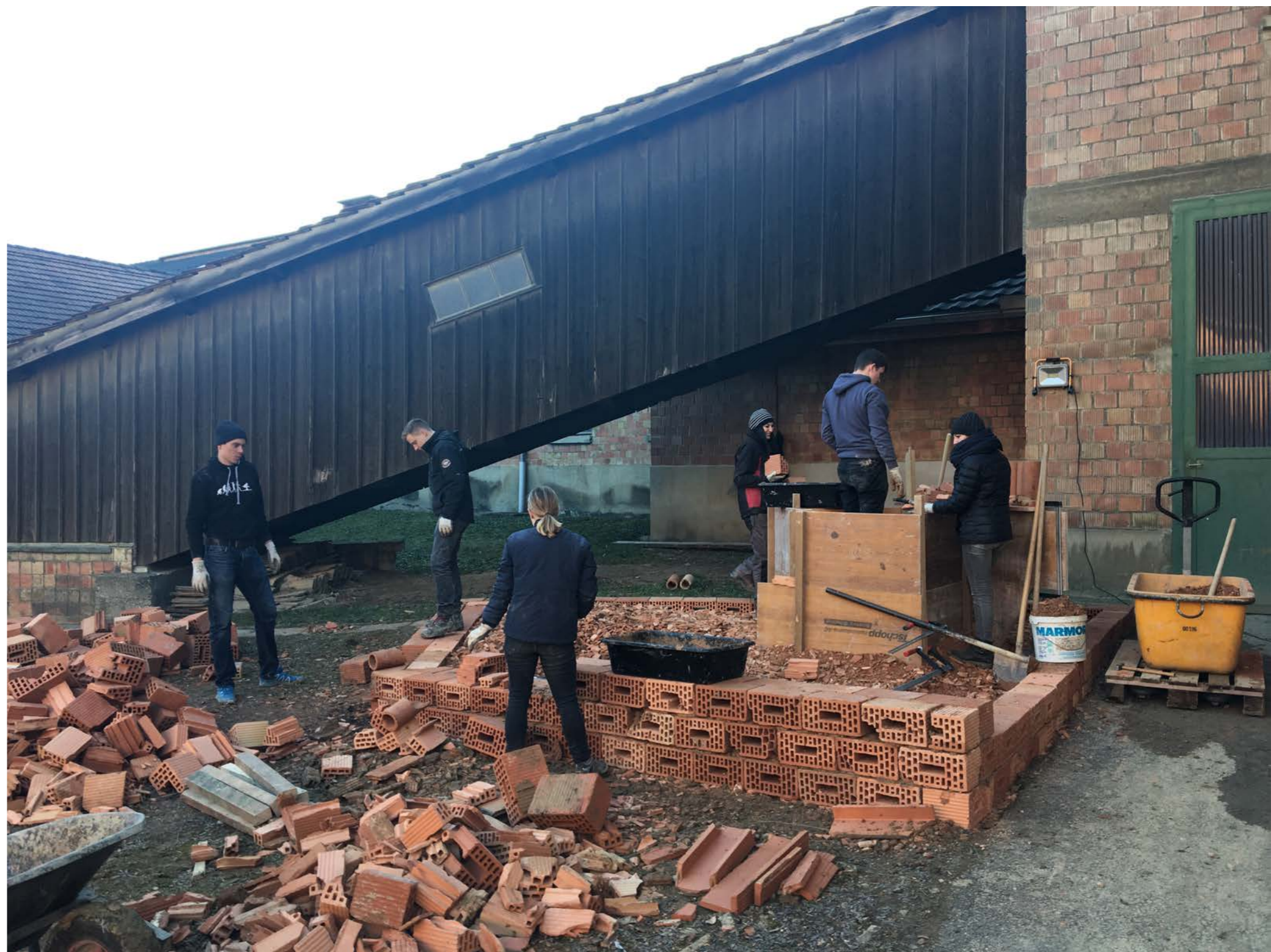
Fabio, Robert, Romina, Evgenia, Remo und Florence arbeiten parallel an Umfassungsmauer und Stampflehtisch
