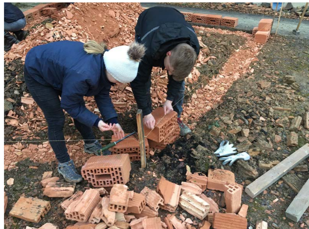
Mauern auf solidem Fundament aus Scherben
