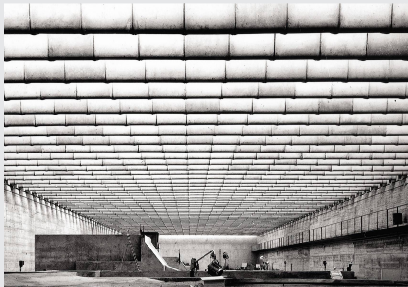
Centro de Estudios Hidrográficos, Miguel Fisac, 1960-1963
