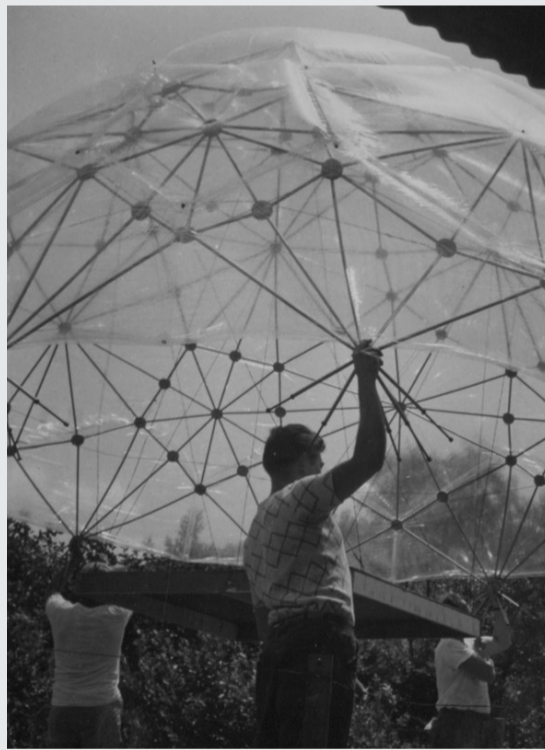
Buckminster Fuller prüft mit Studenten die Stabilität der geodätischen Kuppel, Black Mountain College, North Carolina, USA, 1949. Foto: Masato Nakagawa
